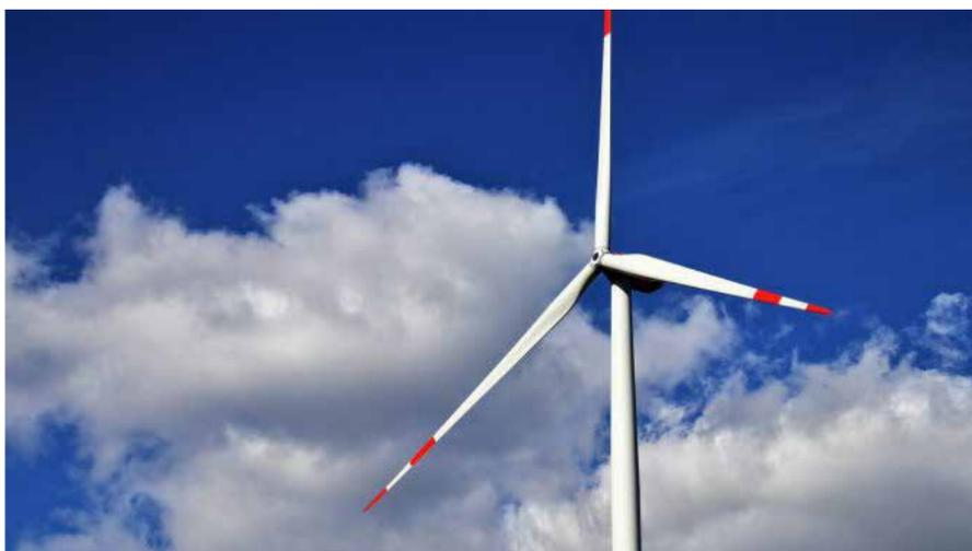
Die Anlage in Puerto del Rosario wird eine installierte Leistung von 29,2 MW aufweisen. Sie besteht aus insgesamt 8 Windgeneratoren mit einer Leistung von jeweils 3,65 MW.
